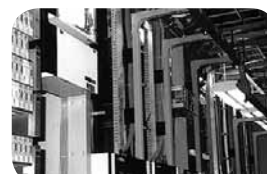
Комплект сплошного вертикального канала 2" x 2" FGS-KTW4-C
